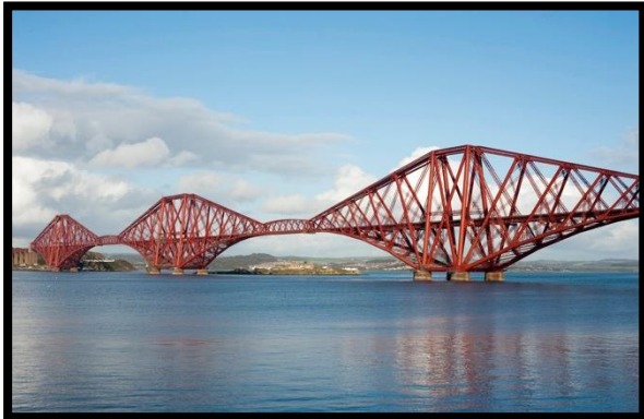
Cantilever (Viga Voladiza)
