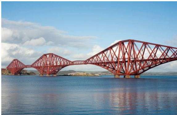
Cantilever (Viga Voladiza)
